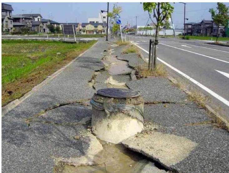
*Рис. 2.6. Повреждение или разрушение систем тепло- и водоснабжения*
