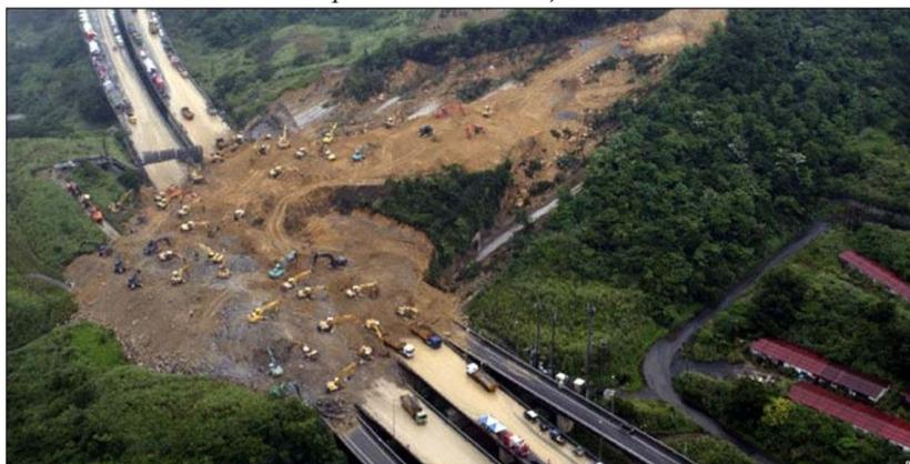
*Рис. 4.6. Сход оползня и его последствия*
