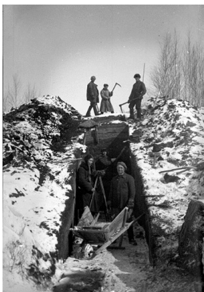
Рис. 1. Фотография работ по осушению Суловской воронки, 1929 г.
