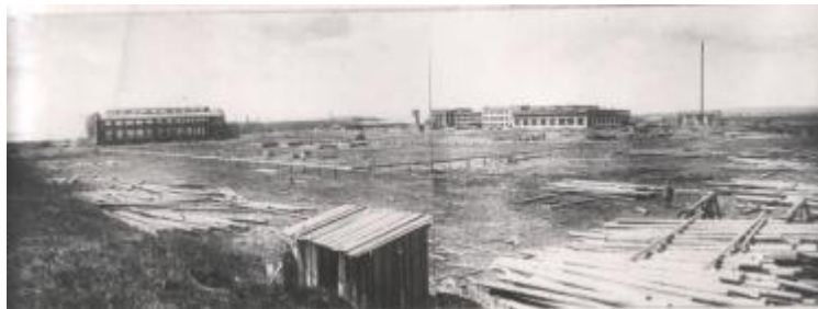
Рис. 10. Панорама строительства завода
