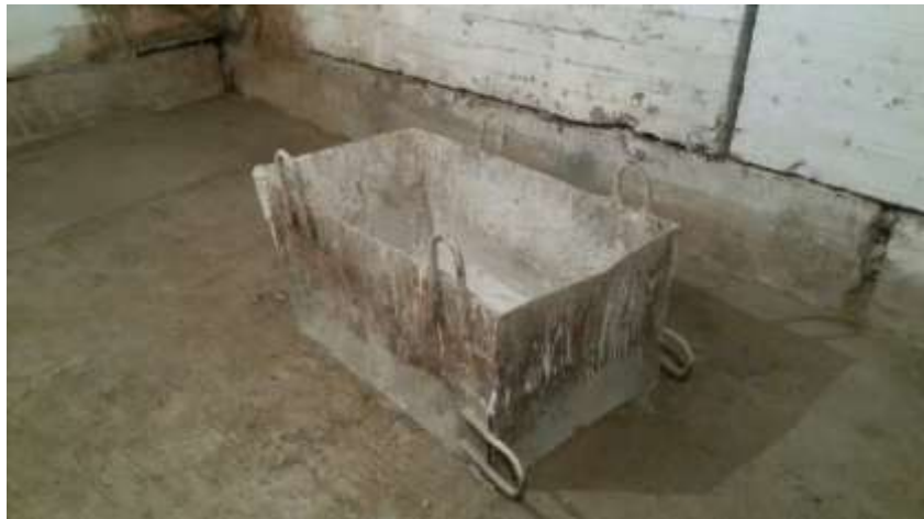
Рисунок 1 – заливка пола бетонной смесью
