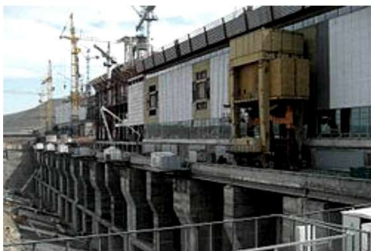
Рис.20. Здание ГЭС со стороны нижнего бьефа [23]
