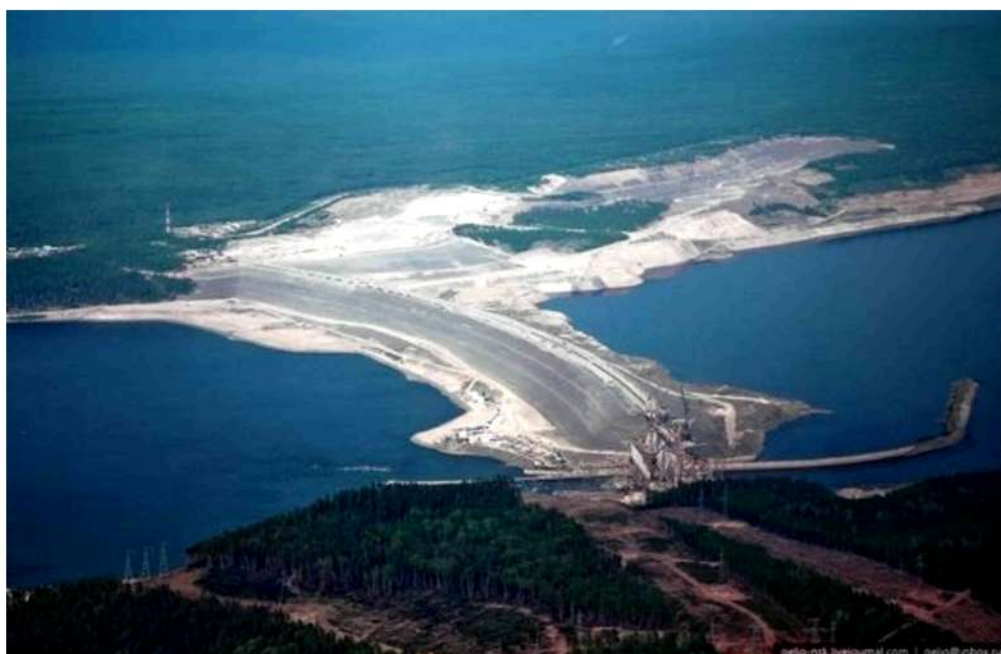
Рис.17. Каменно-набросная плотина Богучанской ГЭС [21]
