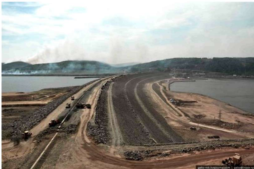
Рис.11. Каменно – набросная плотина Богучанской ГЭС [20]
