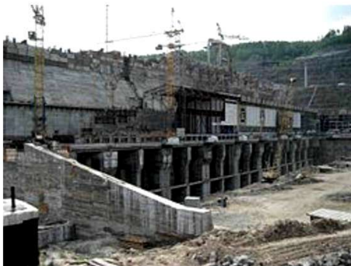
Рис. 25. Строительство Богучанской ГЭС (вид с нижнего бьефа, май 2011 года)[23]
