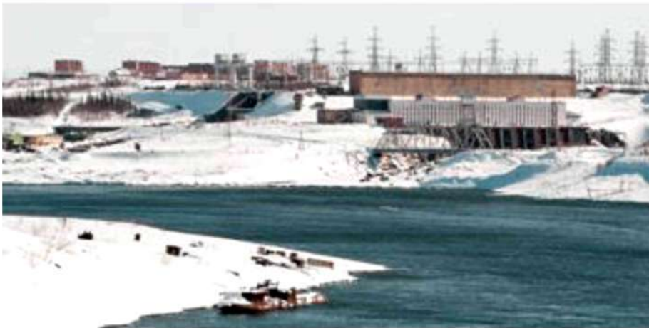
Рис. 16. Не замерзающая полынья Усть – Хонтайской ГЭС [22]
