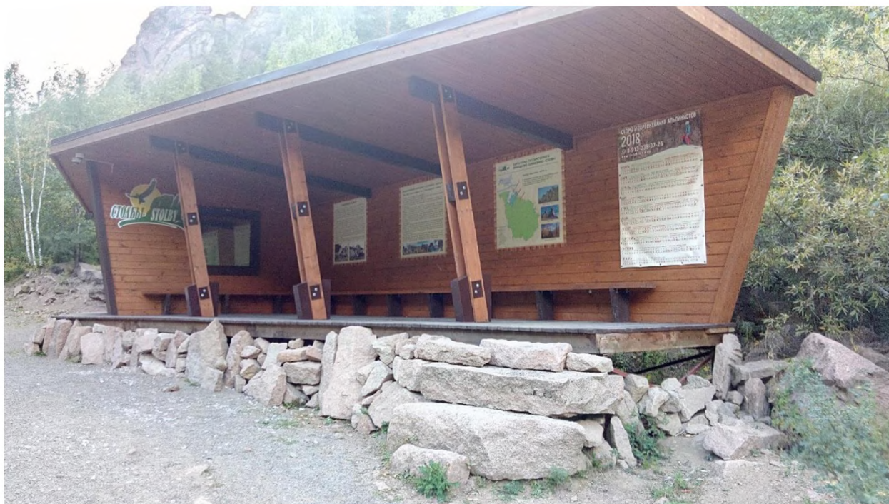
Рис. 27. Здание инспекторского пункта у восточного входа
