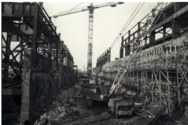
Рис.9. Строительство Надеждинского металлургического завода (1979 год) [39].
