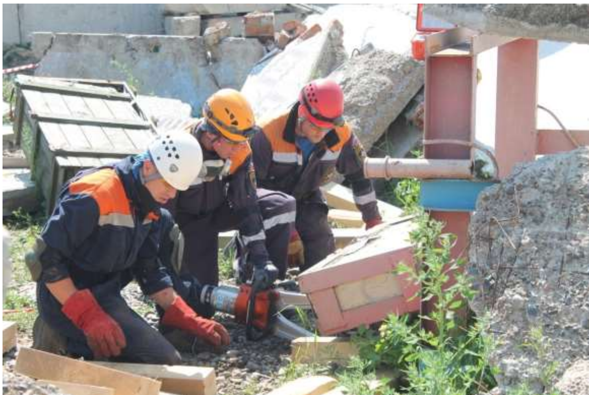
Рисунок 3 – Тренировка на базе СРПСО МЧС России «Подъем плиты гидравлическим инструментом»
