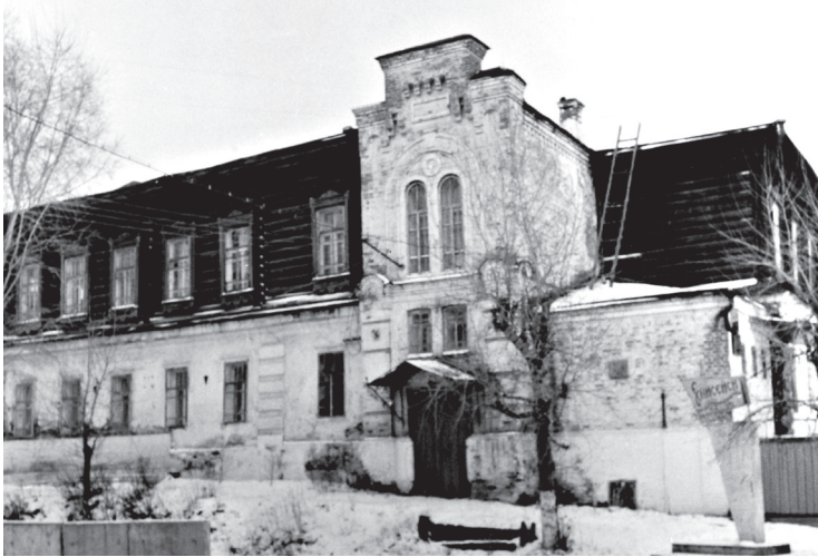
Здание Енисейского приходского училища. Второй этаж пристроен в 1895 г.
