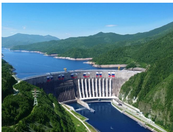
Рисунок 6- Плотина Саяно-Шушенской ГЭС
