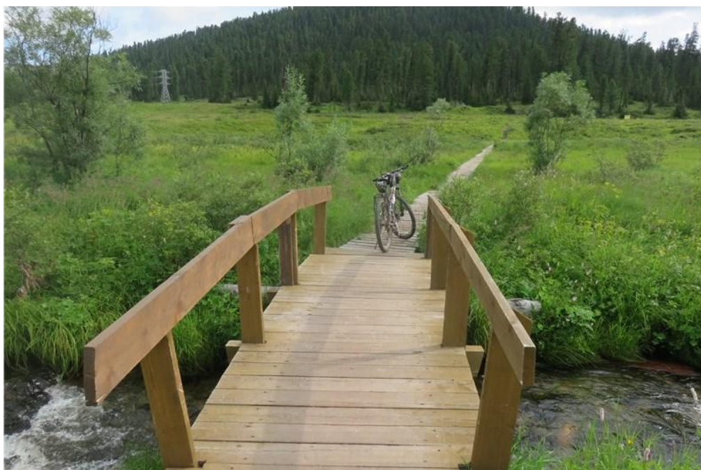
Рис. 26. Мост через Малую Буйбу.
