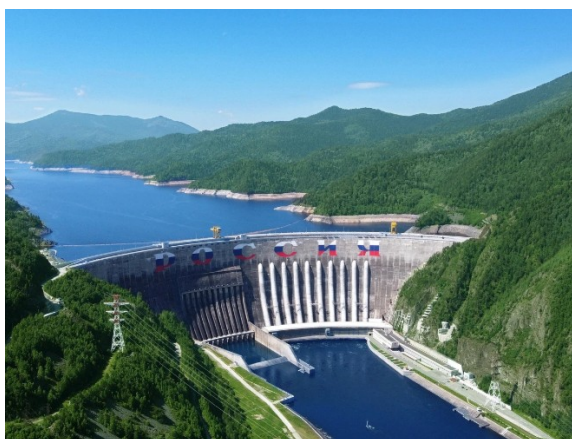
Рисунок 2. Плотина Саяно-Шушенской ГЭС
