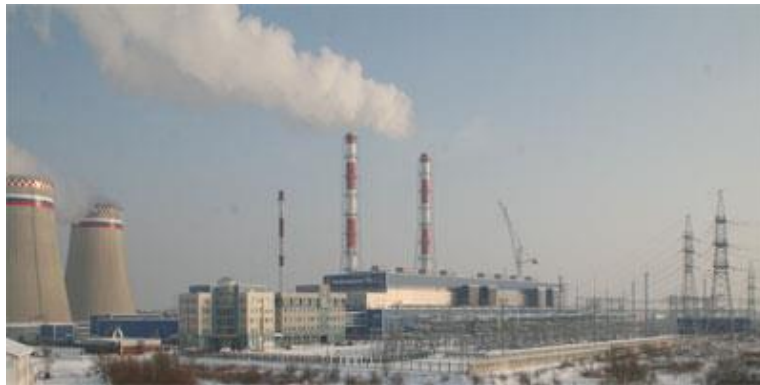
Рис. 10. Калининградская ТЭЦ-2, построенная белорусскими специалистами «Белэнергостроя» [14]
