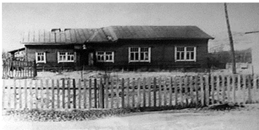
Рис. 2. Здание мерзлотной станции (1934 г.) [2]
