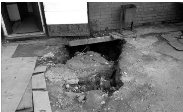
Рис. Суффозионный провал грунта возле одного из навильонов на территории рынка Академгородка
