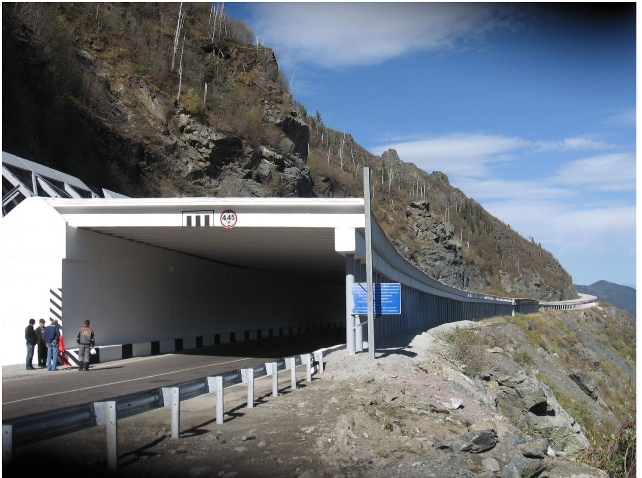
Рис. 6. Противолавинная галерея на трассе М-54 [28]
