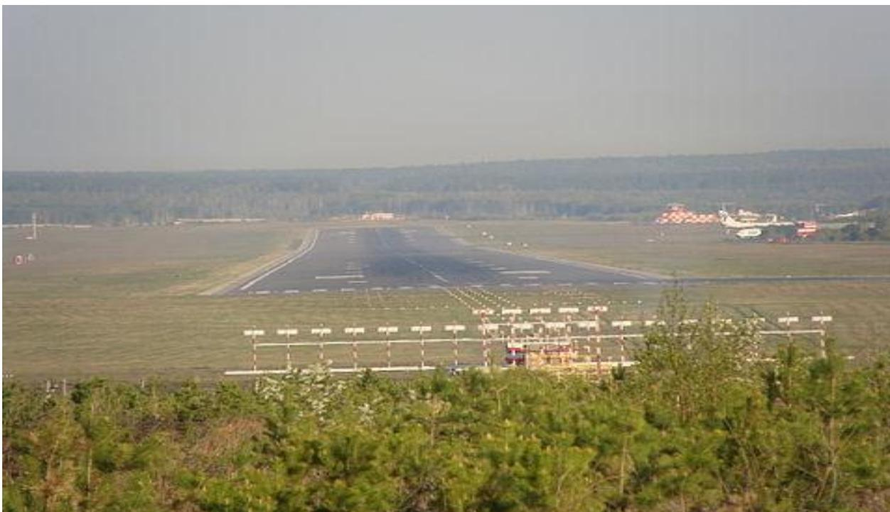
Рис.5. Посадочная полоса оборудованная световой высокоинтенсивной системой
