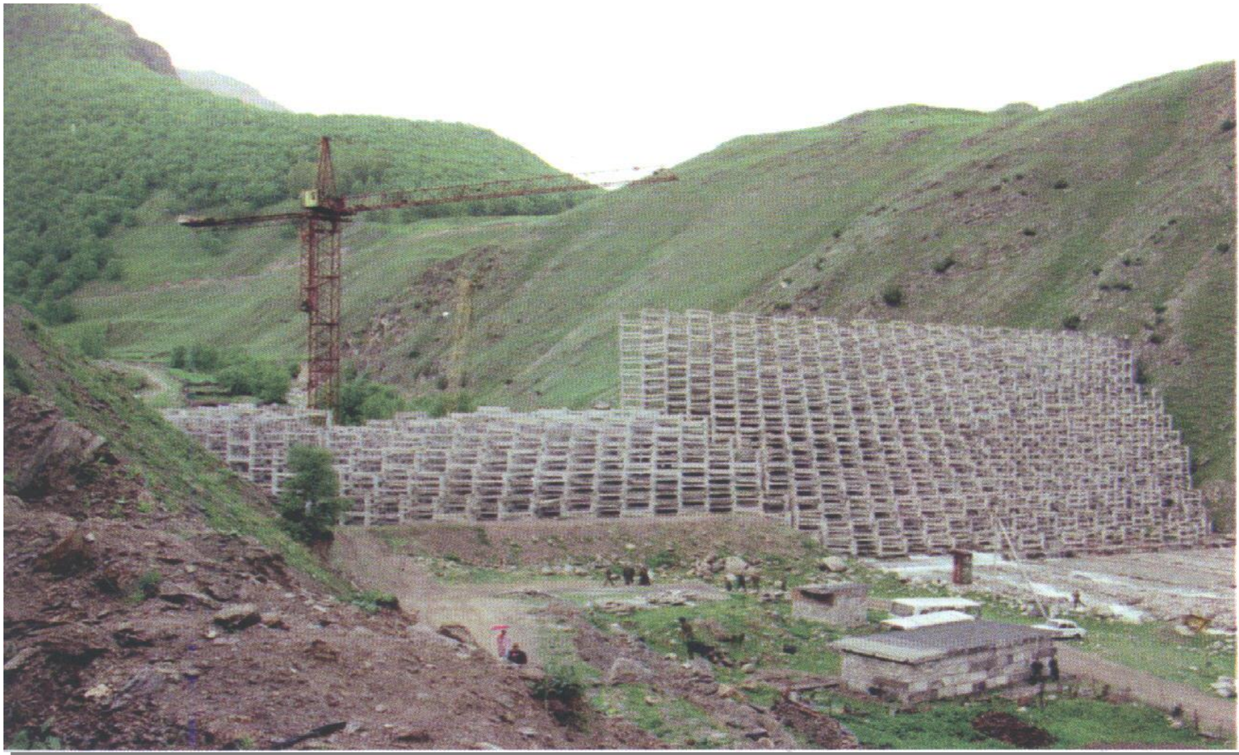
Строительство селезащитной плотины в Кабардино-Балкарской республике
