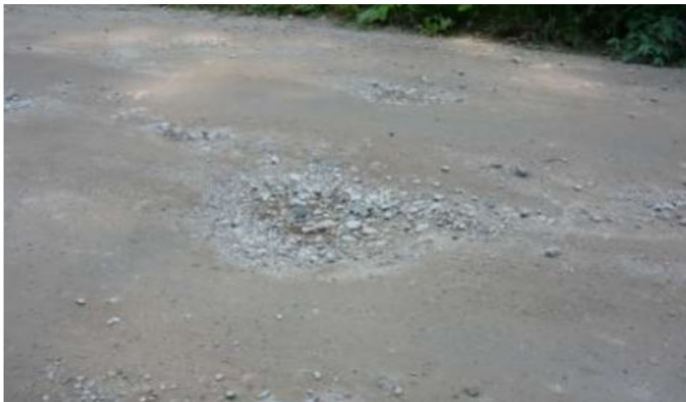
Рисунок 15. Суффозионные воронки на дороге вдоль ручья Моховой.
