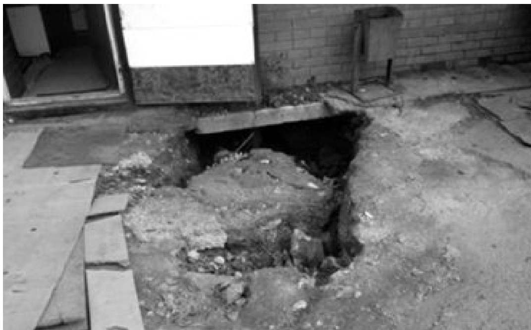
Рисунок 14. Суффзионный провал грунта в районе Академгородка.
