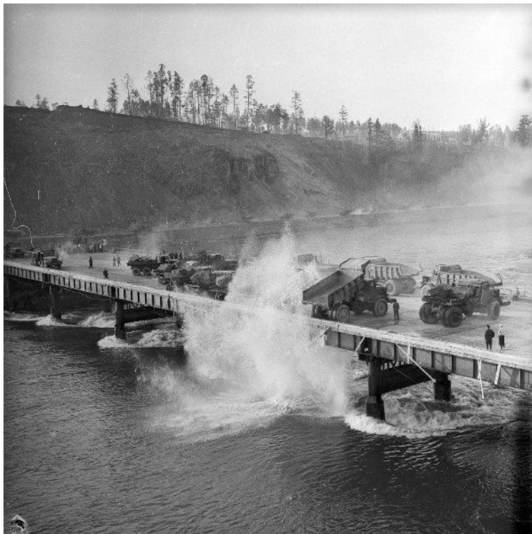
Рис.9. Строительство Красноярской ГЭС [Красноярская ГЭС. История строительства, 2024].
