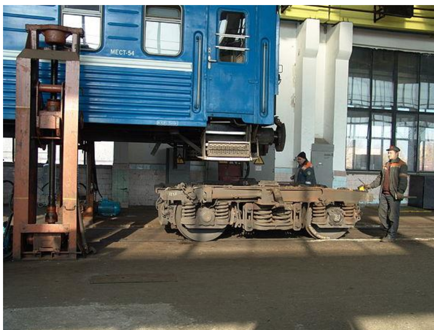
Рис. 13. Подкатка вагонной тележки к вагону
