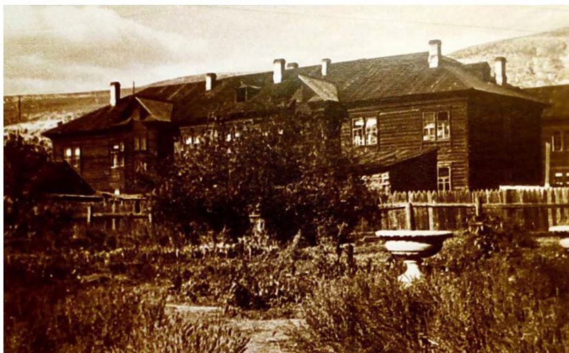
Деревянное общежитие КГПИ по ул. Лассаля, 59 (ныне ул. Брянская)
