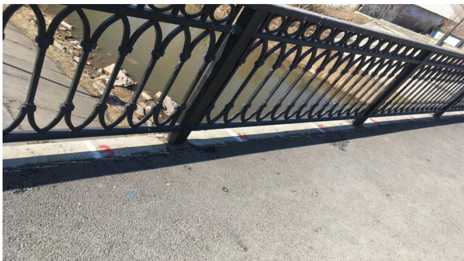
Рис.4.Разметка на мосту, по которой производятся замеры.
