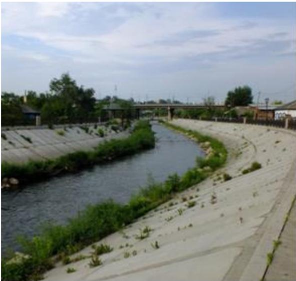
Рис.19. Укрепление берегов р. Качи бетонными плитами
