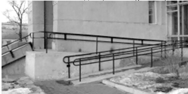
Рис. 41. Оборудование входа института ТЭИ пандусами для опорников
